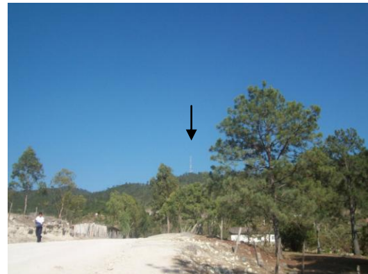
Antena de telefonía celular instalada
